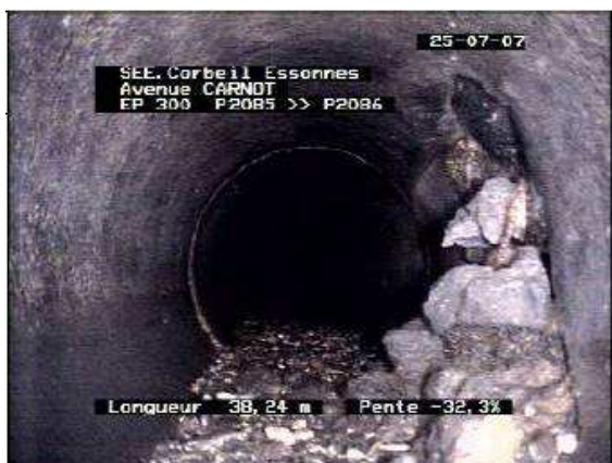
Rue Carnot - Effondrement partiel
