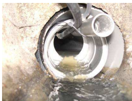
Manchon déversoir installé dans un collecteur
