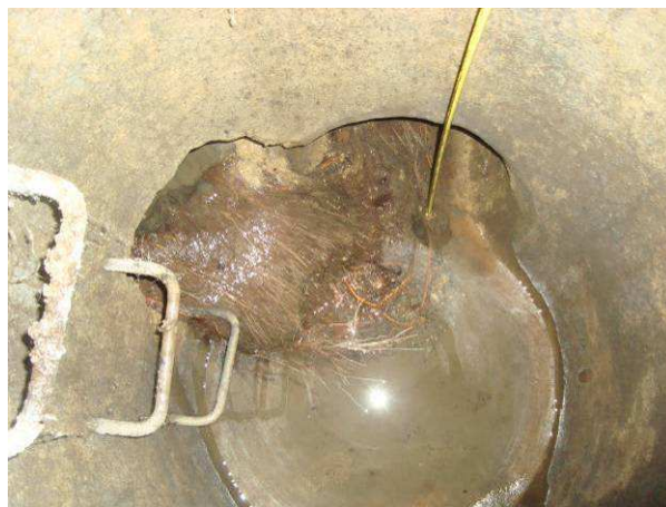
Rue des Fours à Chaux
