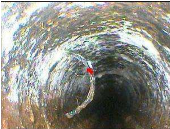
Rue de la Montagne des Glaises - Joint sorti
